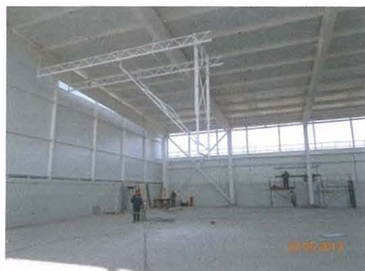
FOTOS N° 3 Y 4 OBRAS INTERIORES EN EL GIMNASIO – ESTRUCTURA DE TABLERO DE BASQUETBOL
