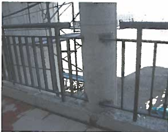
Fotos N° 3 – 4 Encuentro de las barandas del pasillo del segundo y tercer piso con los pilares de hormigón.
