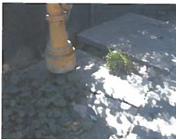
Fotos N° 5 y 6 – Proyecto Rinconada Lo Vial, la losa del grifo está quebrada
